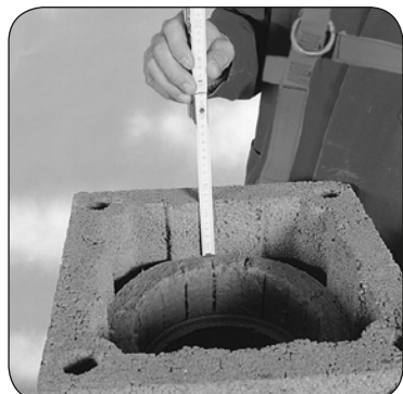
6.1 Wełnę mineralną zakończyć 8 cm poniżej górnej krawędzi najwyższego pustaka.
