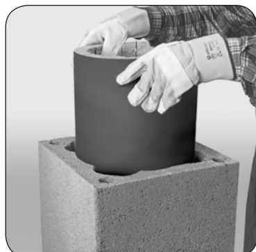
5.2 Wsunąć do pustaka płytę z wełny mineralnej. Miejsce łączenia płyty nie powinno się znajdować w narożu pustaka.
