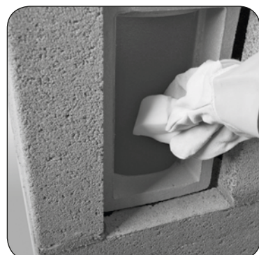
3.9 Wygładzić miejsce połączenia elementów ceramicznych i usunąć nadmiar kitu (np. przy pomocy wilgotnej gąbki).
