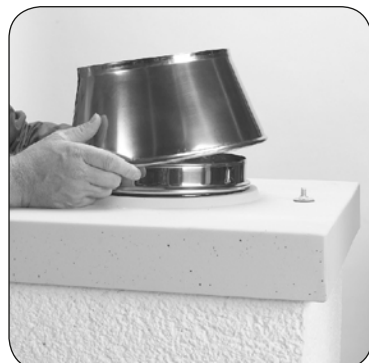
6.3 Przyłożyć stożek wylotu spalin w celu dokonania pomiaru skrócenia ostatniej rury.
