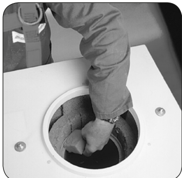
6.5 Przed zamontowaniem skrócić (szlifarką kątową) ostatnią rurę ceramiczną.
