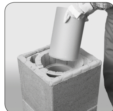
5.4 Na zwilżone dołne złącze rury nałożyć kit. Osadzić rurę i usunąć nadmiar kitu.
