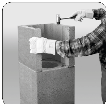
4.2 Osadzić pustak z wyciętym otworem i wypoziomować. Wykorzystując drugą połowę płyty z wełny mineralnej (patrz pkt 2.5) umieścić ją w pustaku, a na górną powierzchnię ścianek pustaka nałożyć zaprawę.
