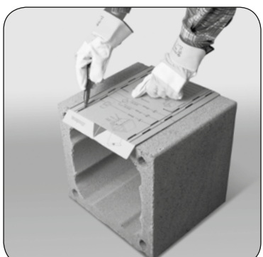
3.1 Na kolejnym pustaku zaznaczyć szerokość otworu do wycięcia (19 cm) na całej jego wysokości.
