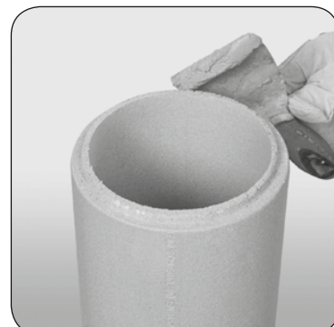
4.3 Zwilżyć dołne złącze rury przyłączeniowej i nałożyć kit kwasoodporny SPK na całym obwodzie.
