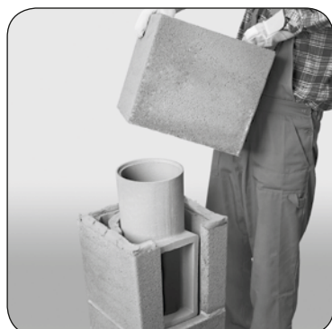
3.10 Osadzić na zaprawie cały pustak.
