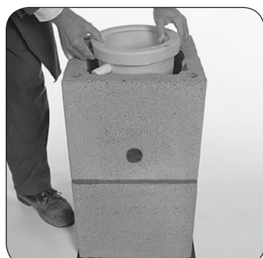
2.3 Pustak osadzić na pokrytym zaprawą cokole. Do środka włożyć kształtkę ścieku kondensatu. Ściek osadzić na zaprawie i skłerosować w stronę otworu.
