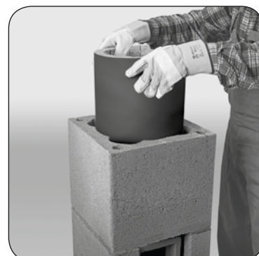
3.11 Wsunąć do pustaka płytę z wełny mineralnej. Miejsce łączenia płyty nie powinno się znajdować w narożu pustaka.
