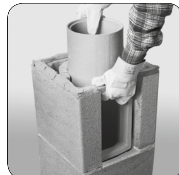
3.8 Osadzić trójnik wyczystkowy na ceramicznej podstawie.
