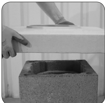
6.2 Na zaprawie montażowej zamontować płytę przykrrywającą.
