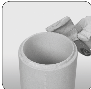
6.7 Osadzić rurę ceramiczną i na jej górną krawędź nałożyć kit.
