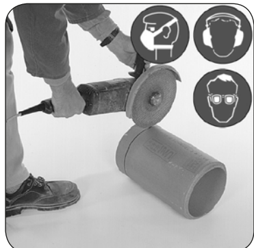
6.5 Przed zamontowaniem skrócić (szlifarką kątową) ostatnią rurę ceramiczną.
