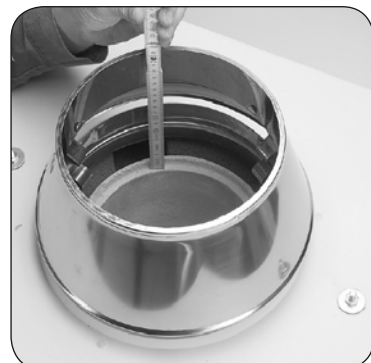
6.4 Odmierzyć brakującą długość rury.
