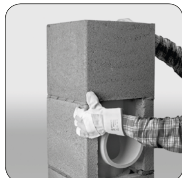
5.1 Osadzić na zaprawie cały pustak.
