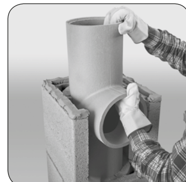
4.4 Osadzić trójnik przyłączeniowy. Wygładzić miejsce połączenia elementów ceramicznych, a nadmiar kitu usunąć.
