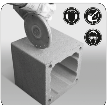
2.2 Wyciąć/wywiercić otwór w dolnej części pustaka, postawić go na warstwie izolacyjnej.
