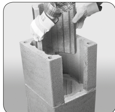
3.5 Płytę z wełny mineralnej przeciąć na pół i jeden kawałek umieścić w pustaku zgodnie z powyższym zdjęciem. Drugi kawałek należy wykorzystać przed osadzeniem trójnika przyłączeniowego (patrz pkt 3.2).
