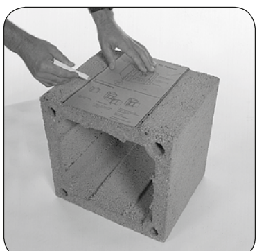
2.1 Wyznaczyć na środku pustaka - 11 cm od jego dolnej krawędzi, otwór do wycięcia o średnicy 40 mm.
