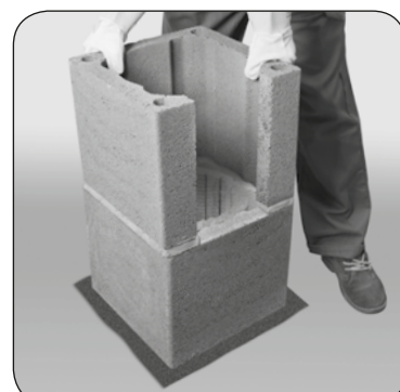
3.3 Osadzić na zaprawie pustak z wyciętym otworem...
